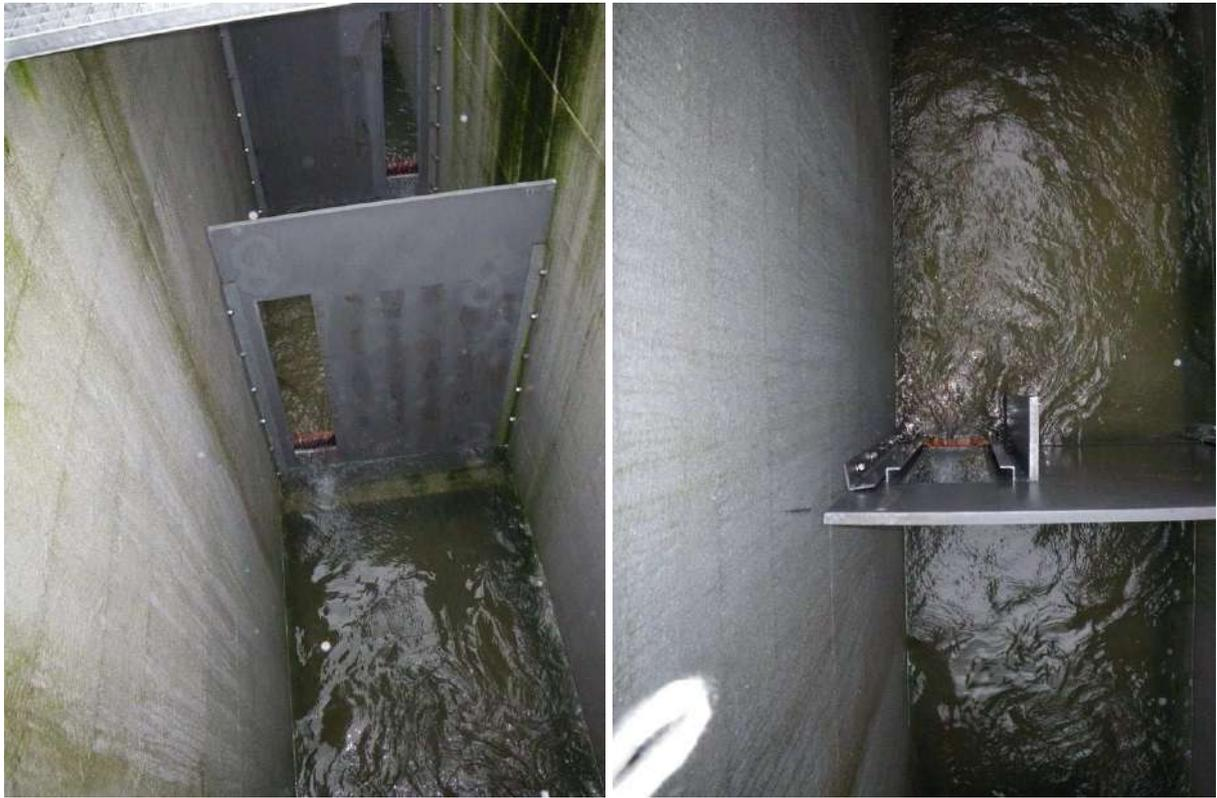
*Paroi métallique vue de dessus ; Détail du déflecteur et des rainures permettant le réglage ou le batardage de l'ouvrage*
