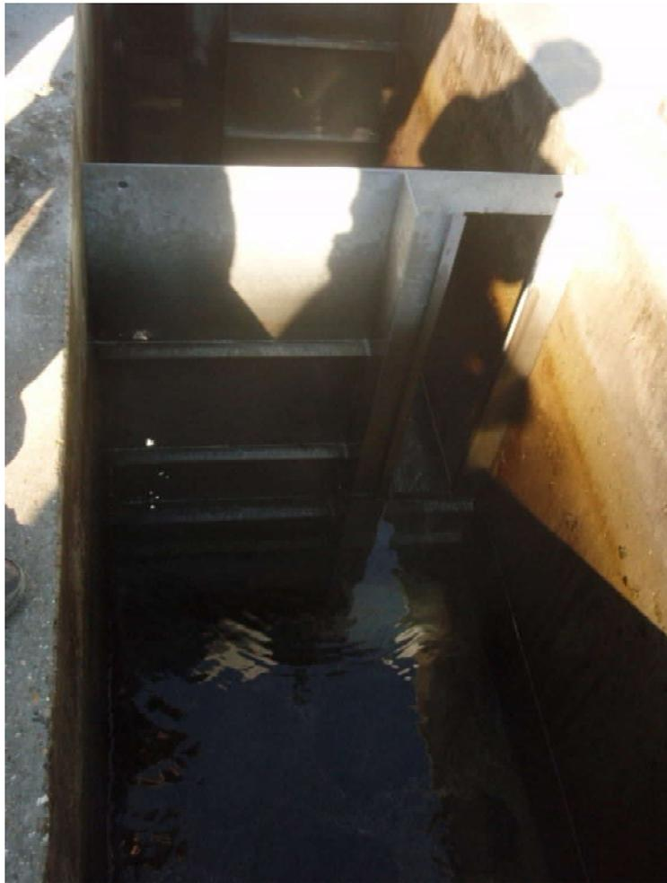
*Cloisons métalliques hors d'eau. A noter les éléments soudés pour la rigidité de la cloison*
