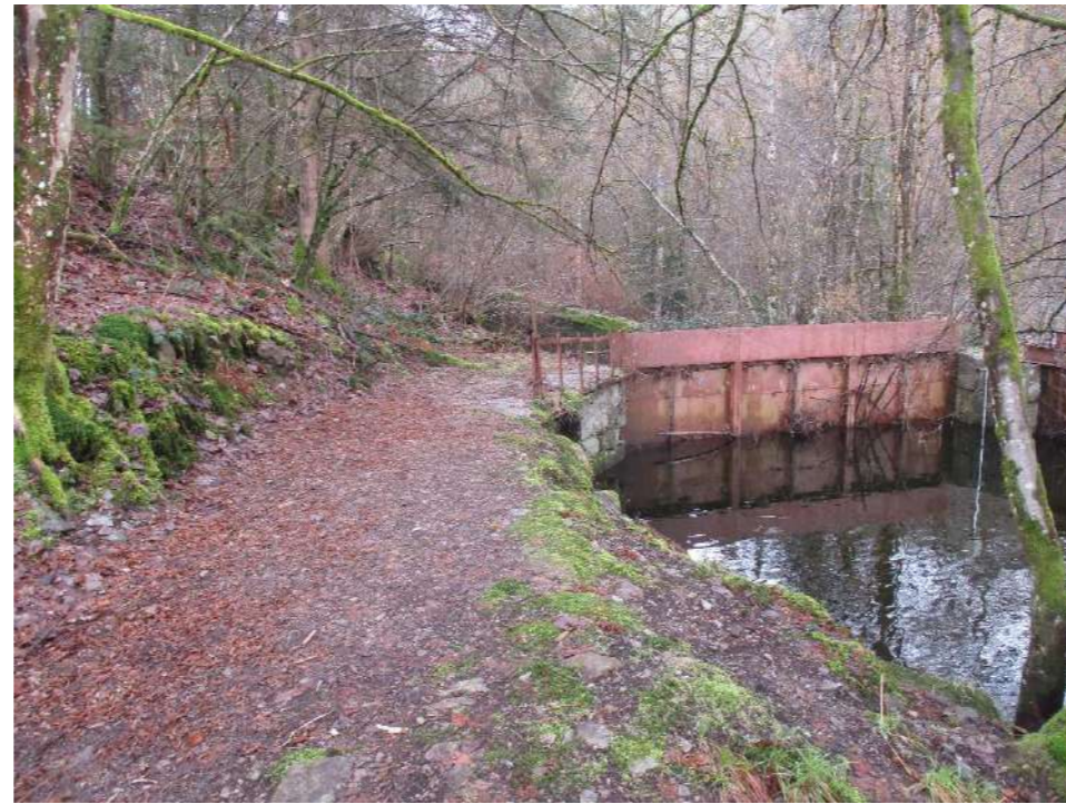
2. Chemin d'accès à la zone de travaux au niveau de la zone de chantier (Vue depuis la rive gauche)
