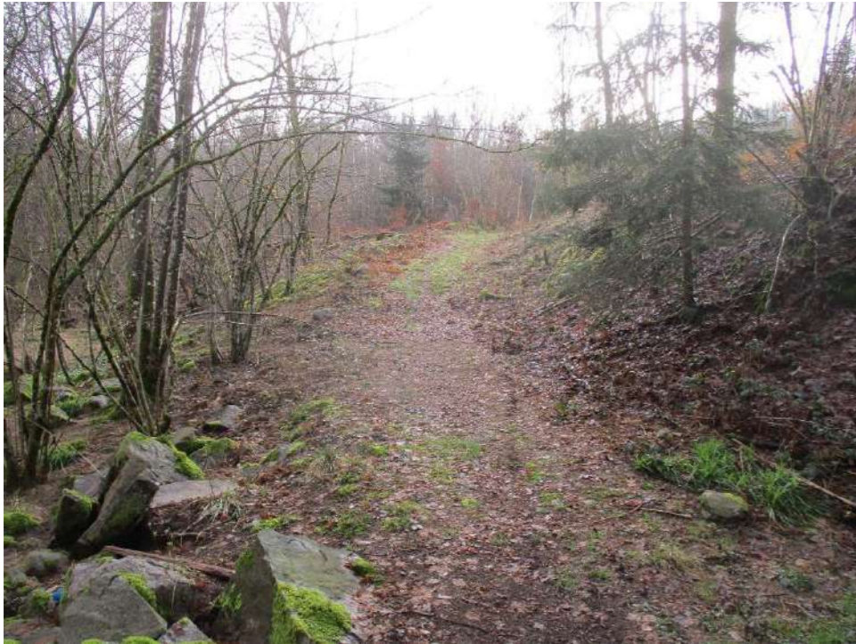
1. Chemin d'accès à la zone de travaux – Partie amont (Vue depuis la rive gauche)
