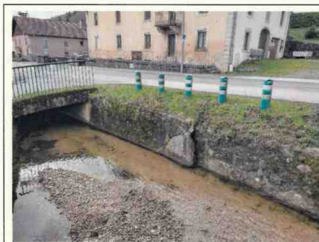
PHOTO N°1 Vue du mur et du ruisseau (vers l'aval)
