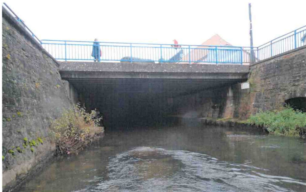
Ouvrage P1188 de Senones (88)
