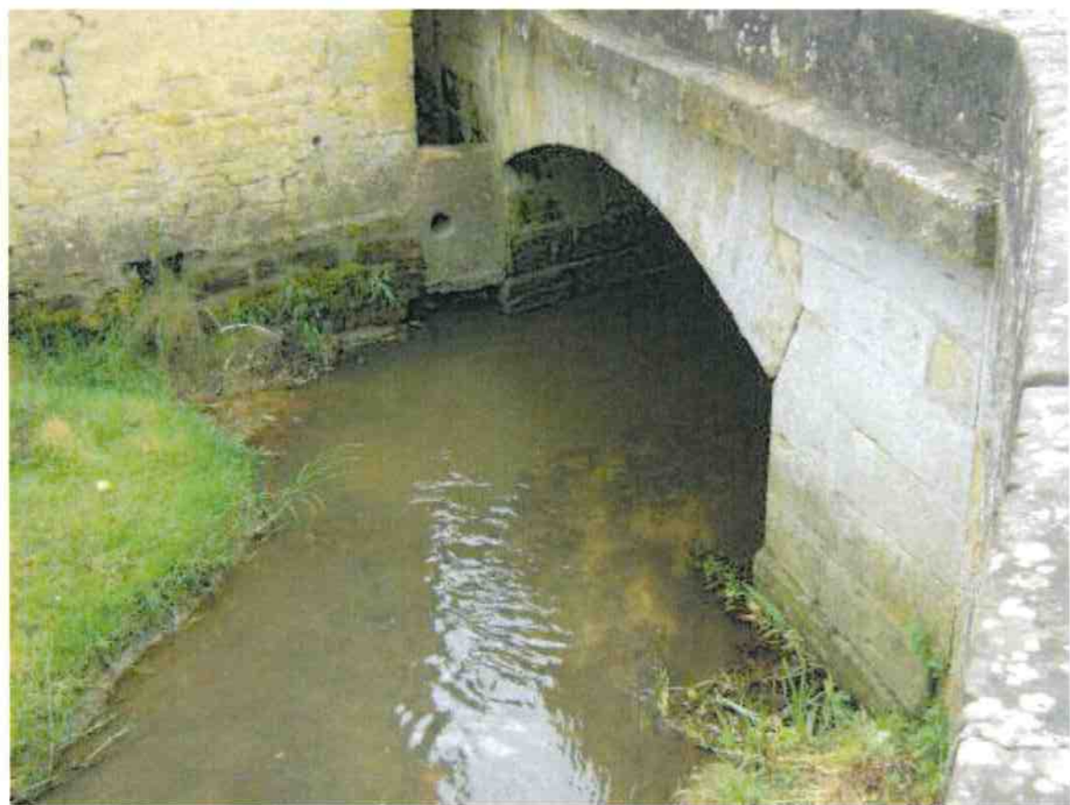
Figure 1 – architecture du pont et situation géographique (document CD88)
