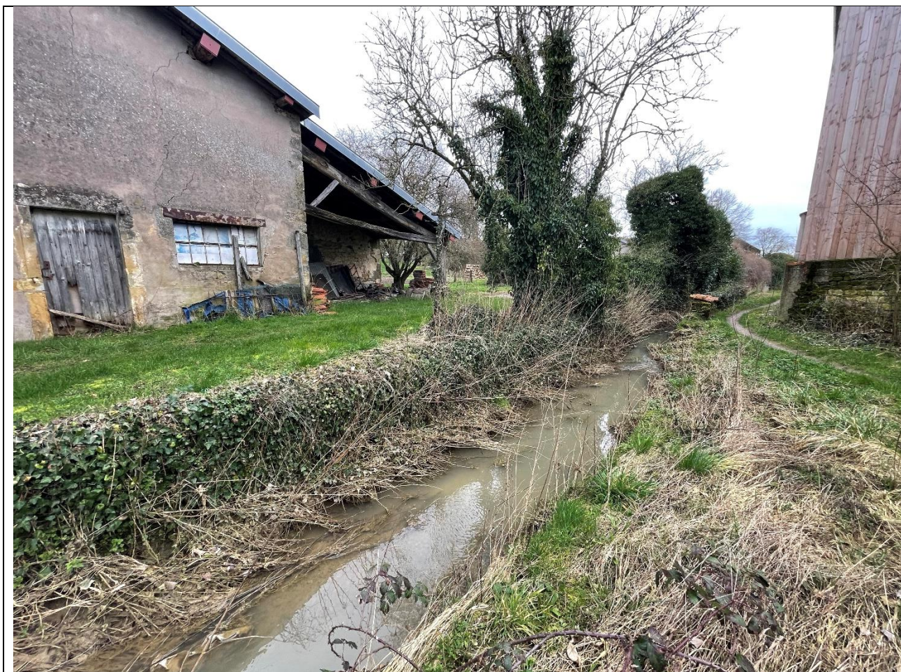
Photo 3 - Vue vers l'AVAL
