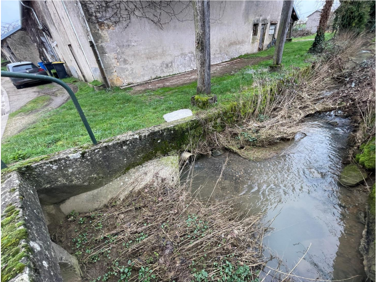
Photo 2 - Vue vers l'AVAL
