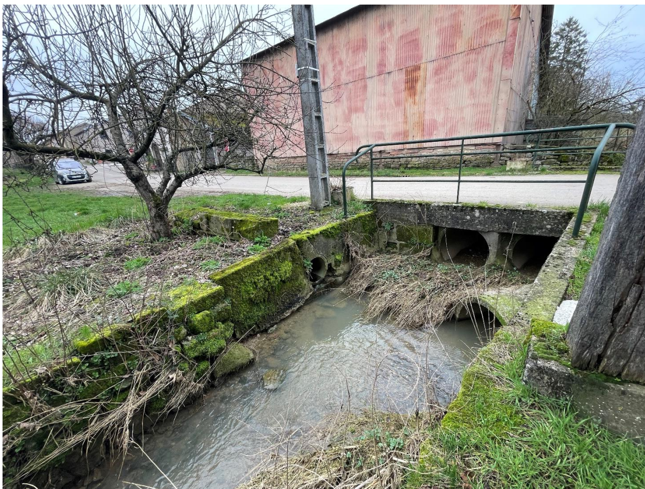
Photo 1 -Vue vers l'AMONT
