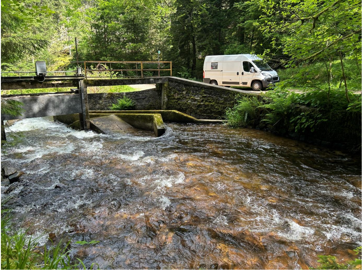
Photo 8 : Lit amont et berges amont
